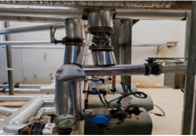
脱硫脱硝工段增加浓水管道
