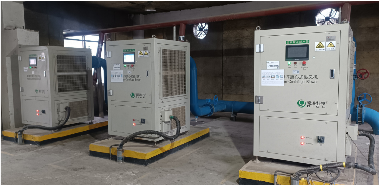
古井贡酒污水处理站低噪声磁悬浮曝气机
