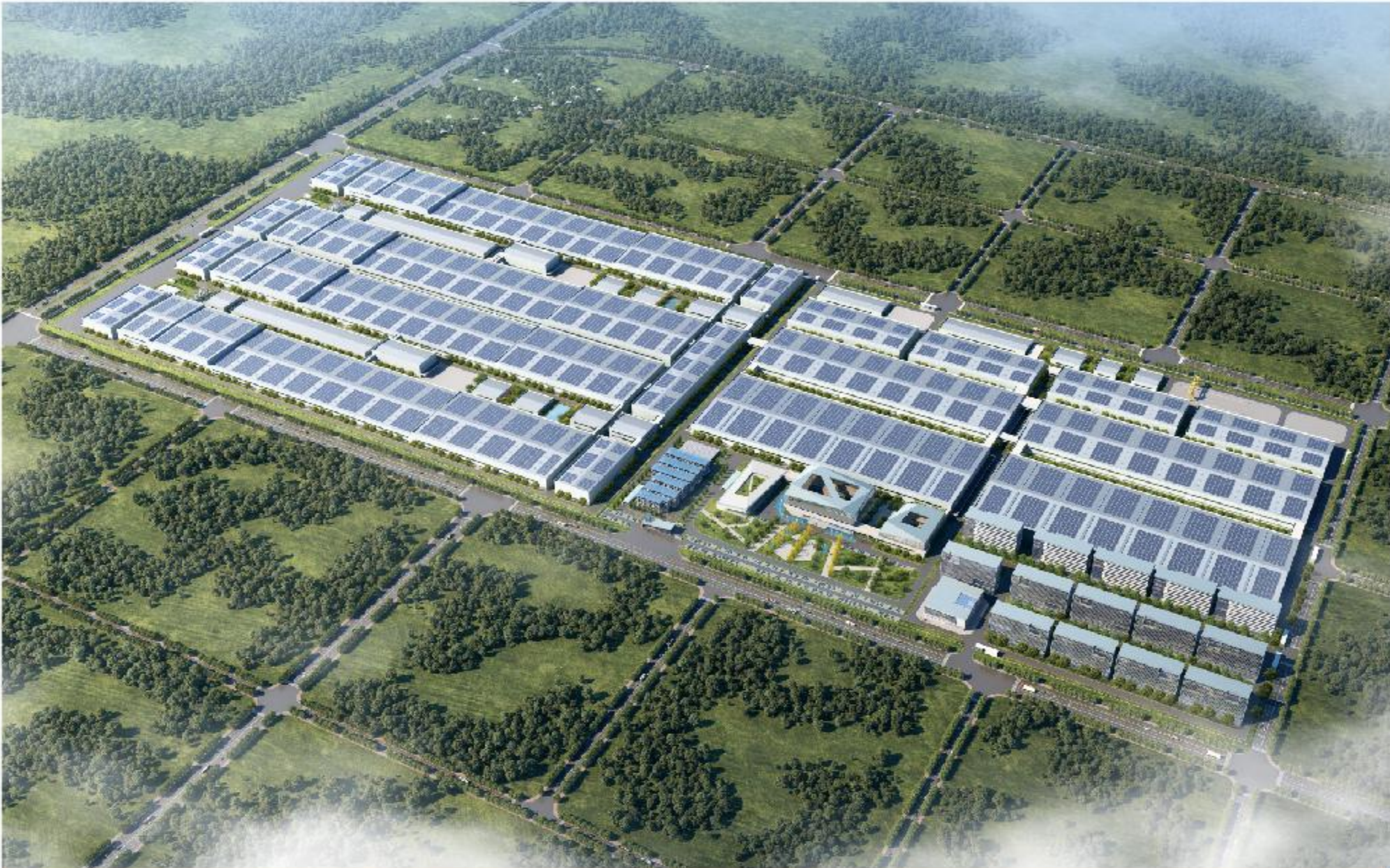
建工三建承建的衢州极电84万套动力电池包、三合一电驱、储能项目及240Wh动力电芯项目荣获“中国钢结构金奖”
