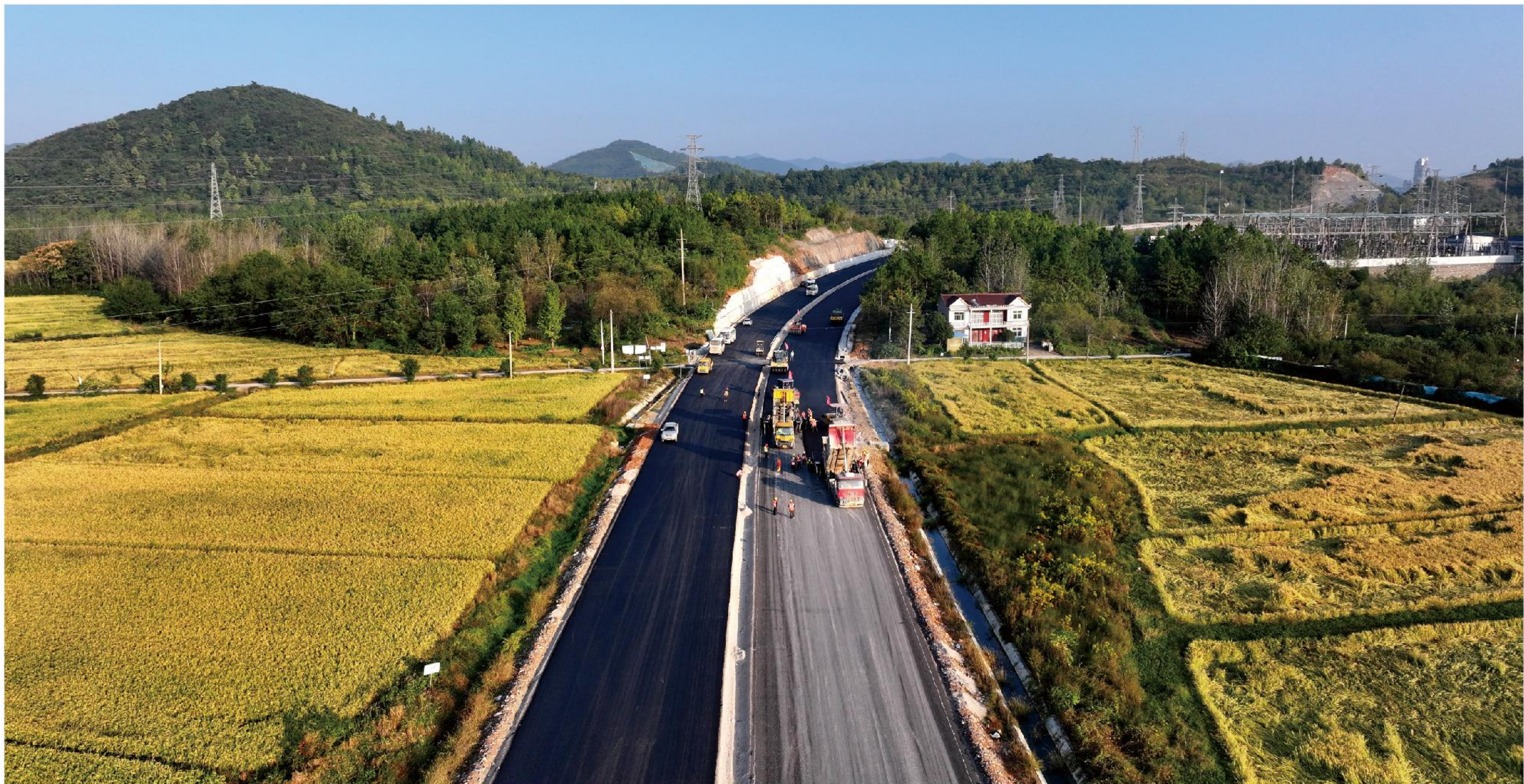
G329孙埠至大汪村段一级公路改建工程
