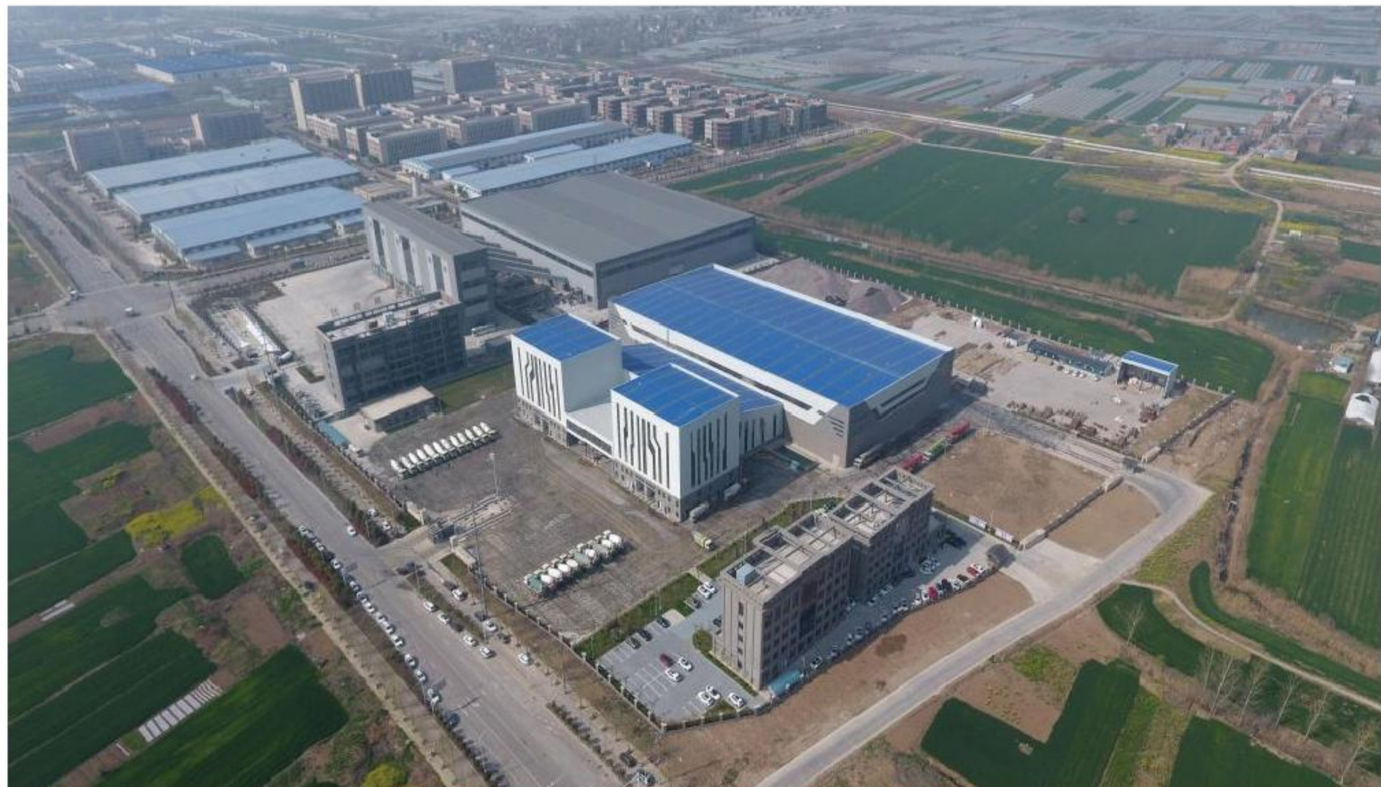
公司所属蚌埠建材产业园
