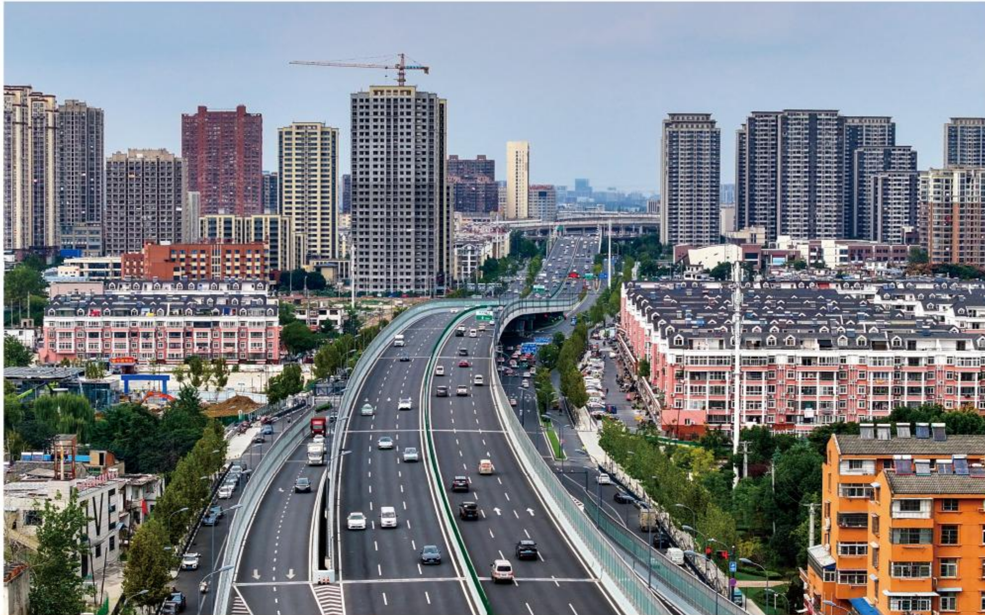
建工路桥承建的郎溪路（裕溪路-明皇路）工程一标项目获市政工程最高质量水平评价奖
