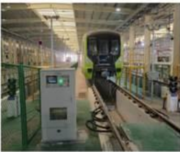
可视化接地验电装置和防误系统
